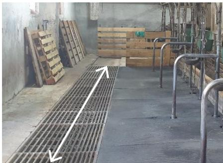
FIGURE 30 : EXEMPLE DE GRILLES DE CANIVEAUX PAR GRAVITE
